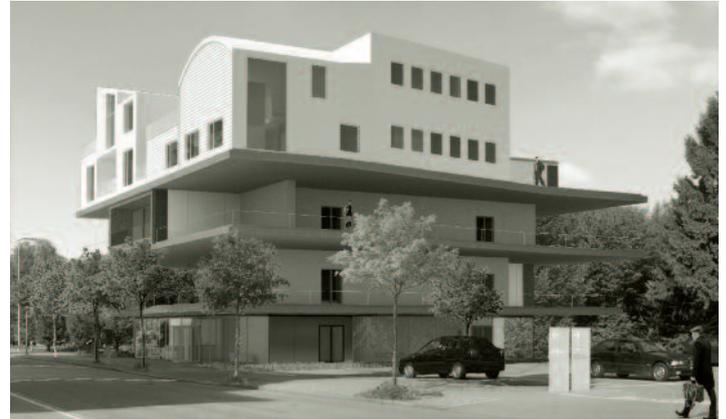
NEST besteht aus einer zentralen Struktur, dem «Backbone». Dieser stellt die Tragkonstruktion und die notwendigen Medien (Elektrizität, Wasser usw.) für die experimentellen Wohn- und Arbeitsräumen zur Verfügung.
